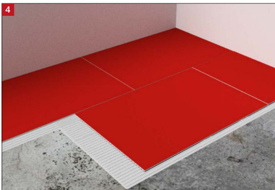
Ultralight debe colocarse sobre mortero adhesivo recién y cuidadosamente aplicado para garantizar que no queden huecos debajo de los paneles y que estén bien apoyados. Todos los paneles deben colocarse con juntas escalonadas.
