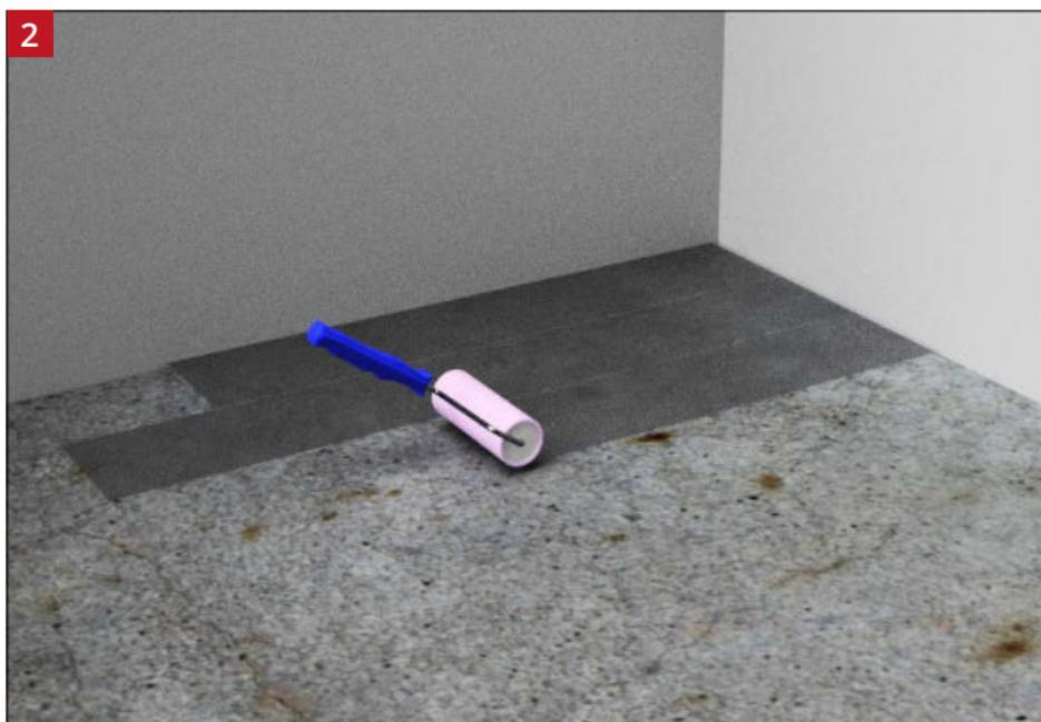
Imprima el subsuelo con una solución de SBR diluida (1:4). Para los subsuelos patentados, consulte las instrucciones del fabricante.
